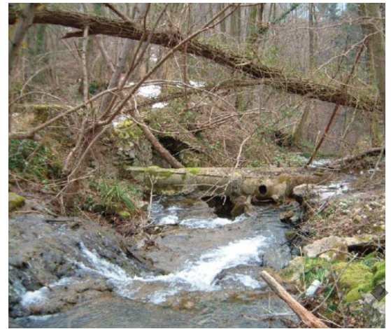
Vestiges de l'ancienne conduite forcée en ciment
